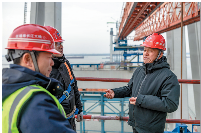
王力在张靖中长江大桥项目施工现场带班检查。张正培 摄影
