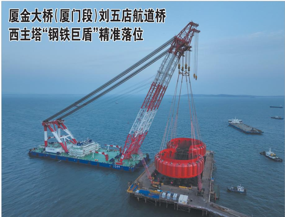
3月9日,厦金大桥(厦门段)项目关键控制性工程刘五店航道桥迎来又一个里程碑时刻——西主塔承台钢套箱精准安装落位,为后续主塔承台施工、塔柱爬升奠定坚实基础。
