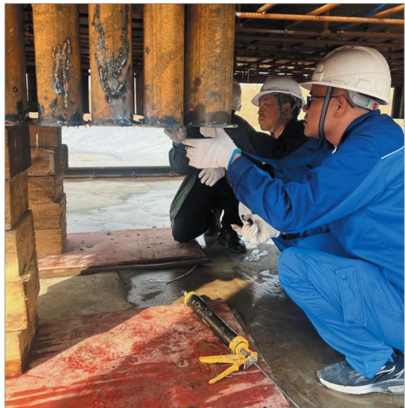
杨林(中)带领项目技术团队成员正在检查UHPC-NC组合盖梁内模底部穿筋孔牢固性和密封性。 田颖 摄影
