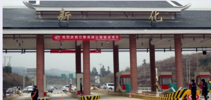
三黎十五标建设的新化收费站启用
