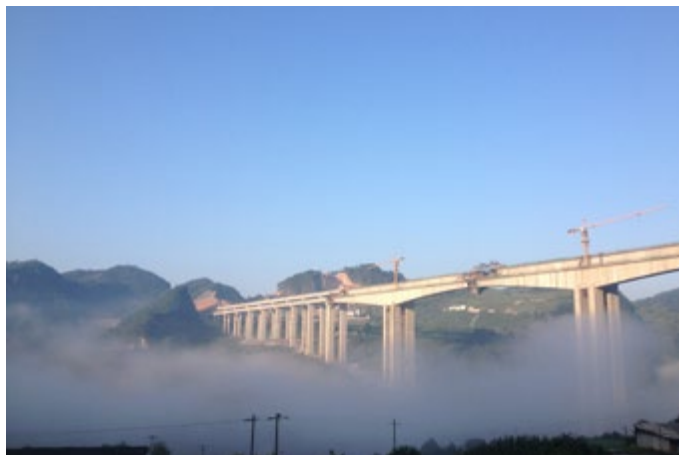
曙光云雾中的石桥特大桥
