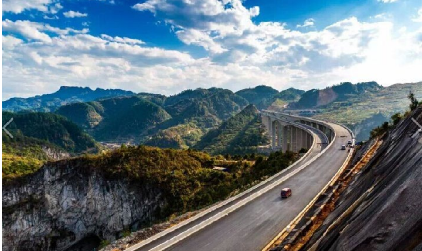
通车后的石桥特大桥在阳光下的矫健英姿
