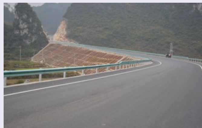
惠罗2+3项目断杉互通区路基
