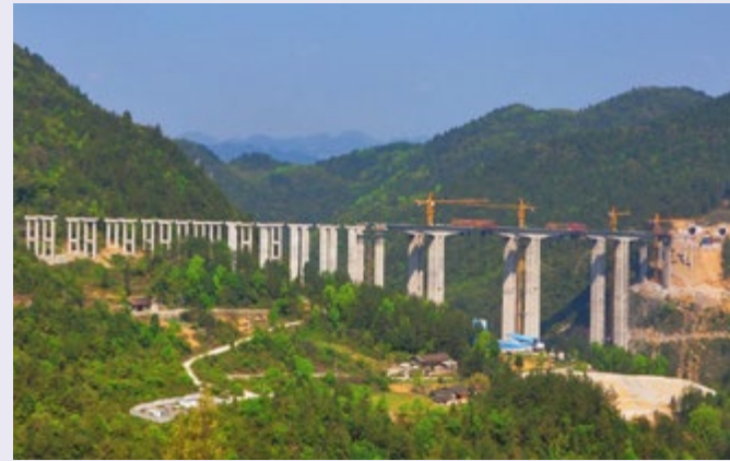
恩来恩黔项目康家河大桥
