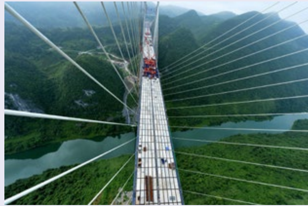
恩来恩黔项目忠建河大桥
