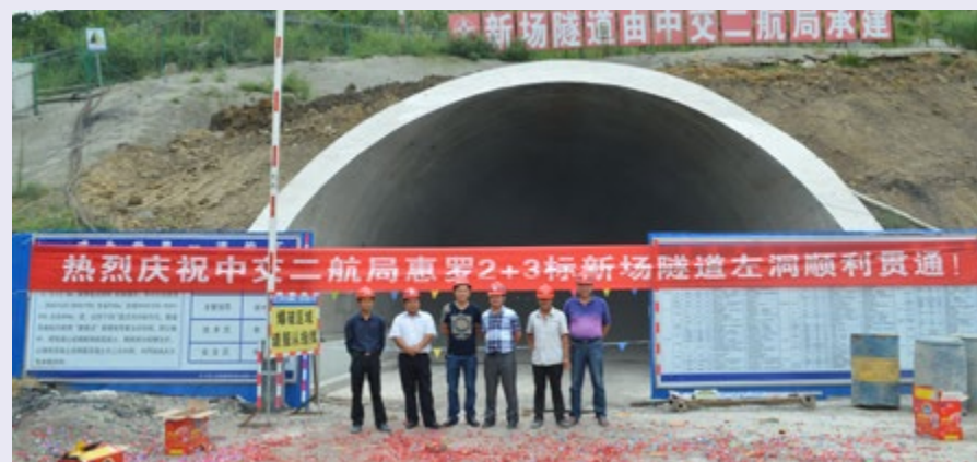
惠罗2+3项目新场隧道左洞贯通
