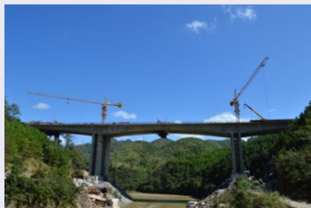
惠罗2+3项目河坝连江大桥全貌
