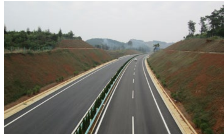
凯羊路面形象进度照片
