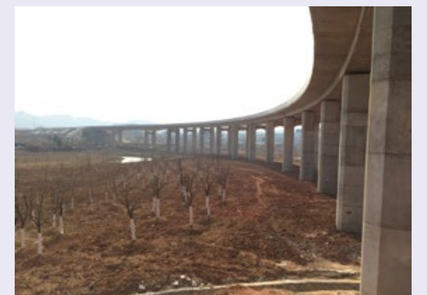
上跨昌九高速公路B匝道桥
