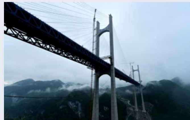
恩来恩黔项目忠建河大桥全貌
