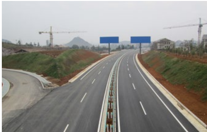
凯羊路面项目丹寨互通形象进度照片
