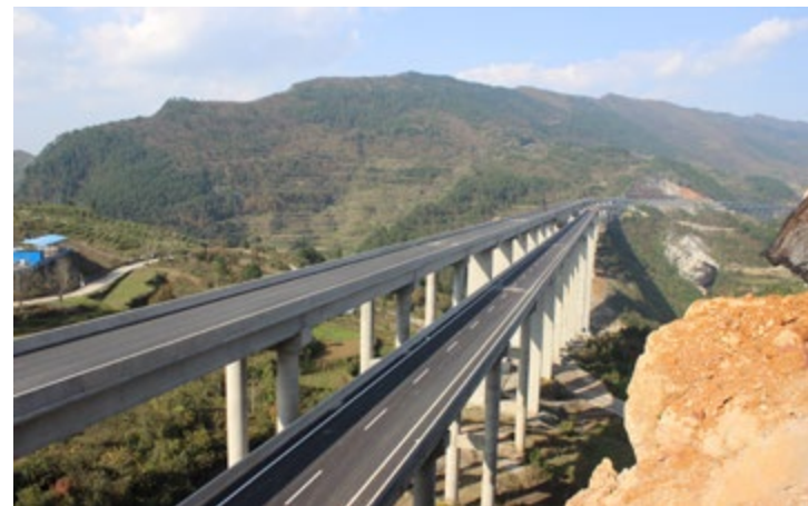
凯羊高速项目建成通车之石桥特大桥照片
