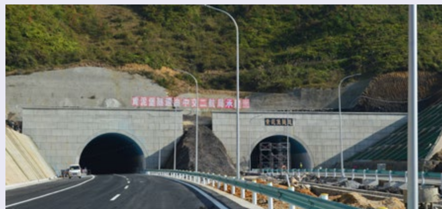
惠罗2+3项目黄泥堡隧道（出口）
